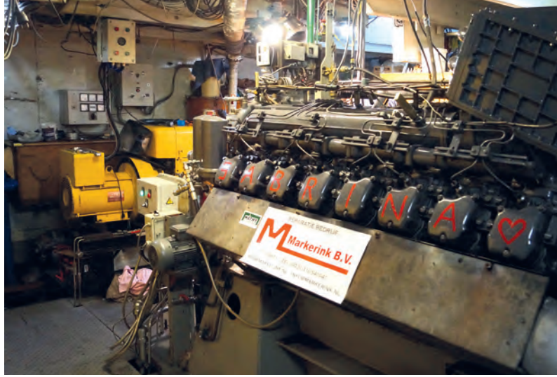
Der Deutz 816 mit 16 Zylindern schafft mit KWE jetzt ZKR II | Bilder: Privat
